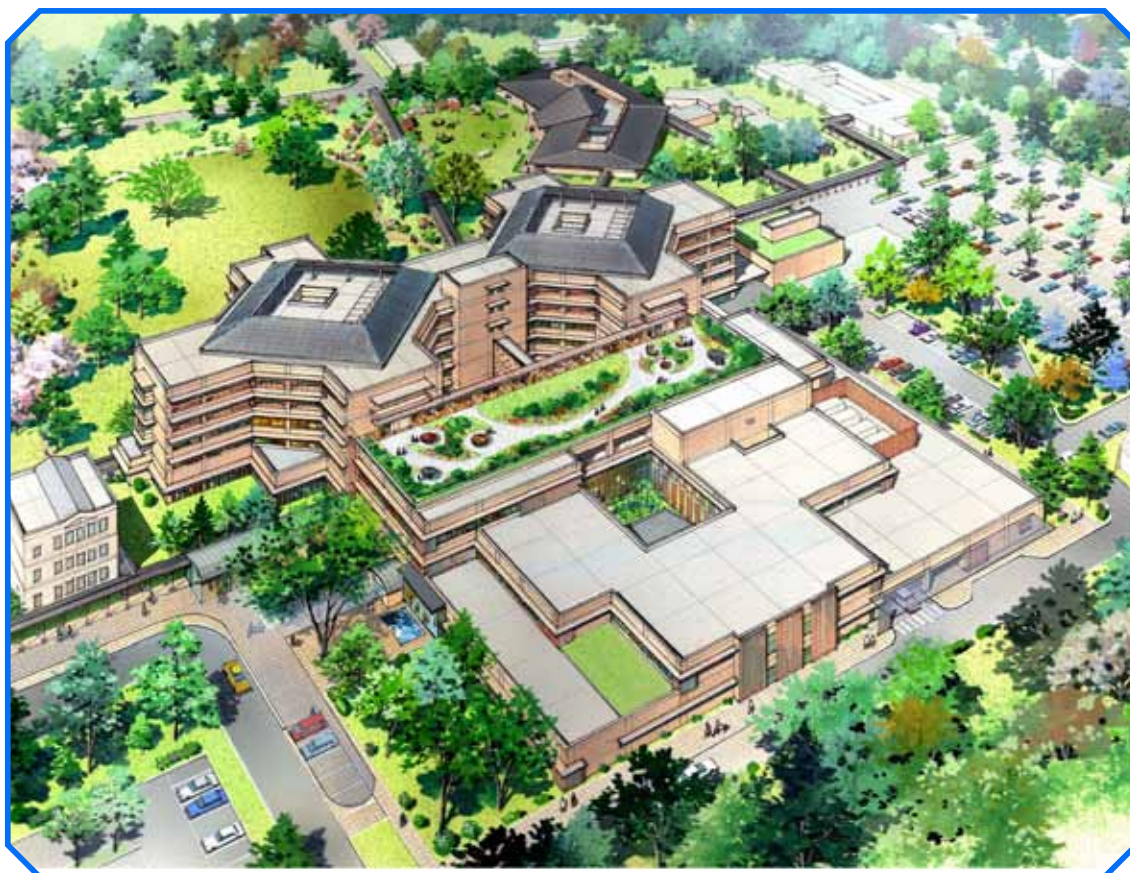
平成22年春完成予定の新病院
